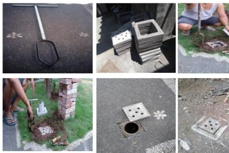
Gambar 3.1 Rangkaian Prosedur Pemasangan Biopori
