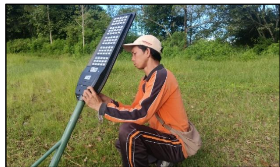
Gambar 10. Praktik pemeliharaan lampu tenaga surya
