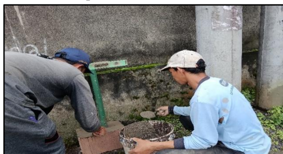
Gambar 5. Pemasangan tiang lampu panel surya
