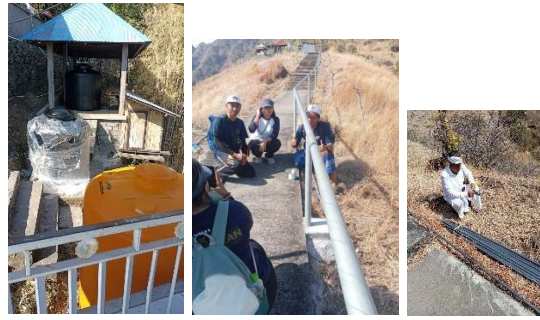
Gambar 3. hasil pemasangan pipa air di sampin tangga.
