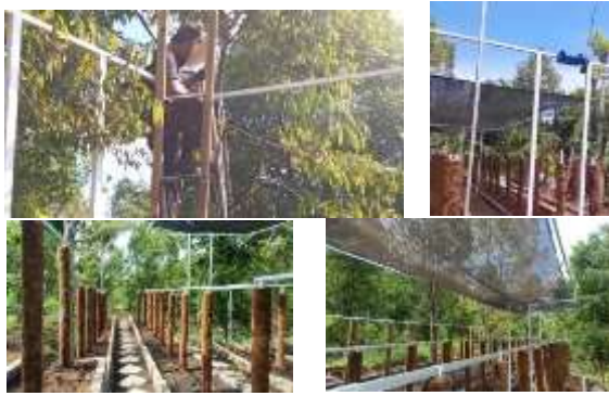
Gambar 5. Pemasangan Tajar Vanili
