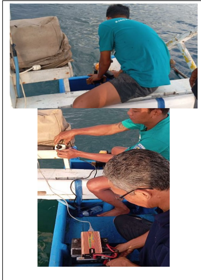
Gambar 7. Instalasi Sistem Penggerak Motor Listrik Pada Perahu Nelayan
